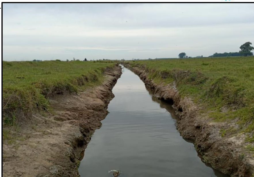
Figura 3. Zona con canalizaciones realizadas.
